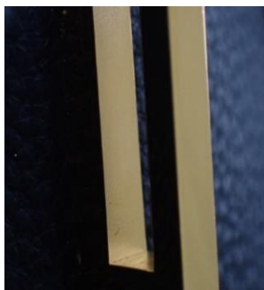
⑮U字金具内側処理
